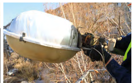
Замена светильников в ходе модернизации
