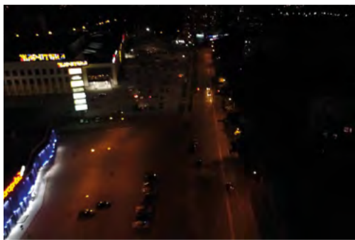
ул. Богородского, до модернизации
